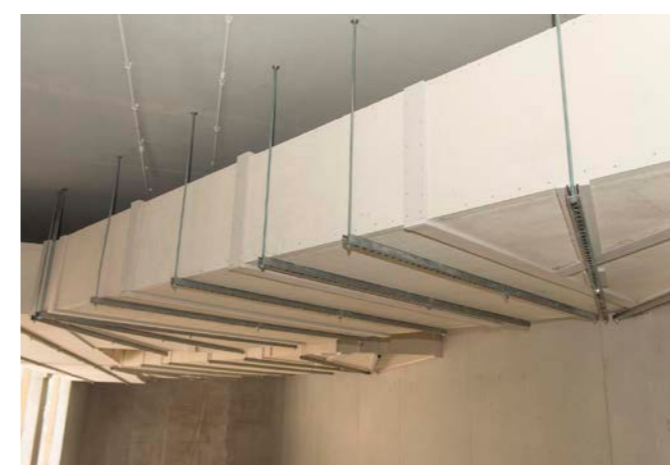
Rys. 1. Trójścienny przewód PROMADUCT®-500 o przekroju wewnętrznym do 1,25 m 2
